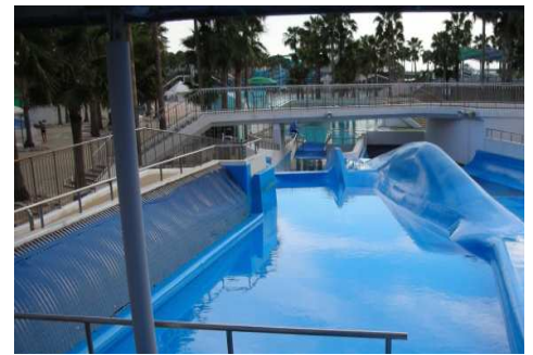
プールの修復コーティング
